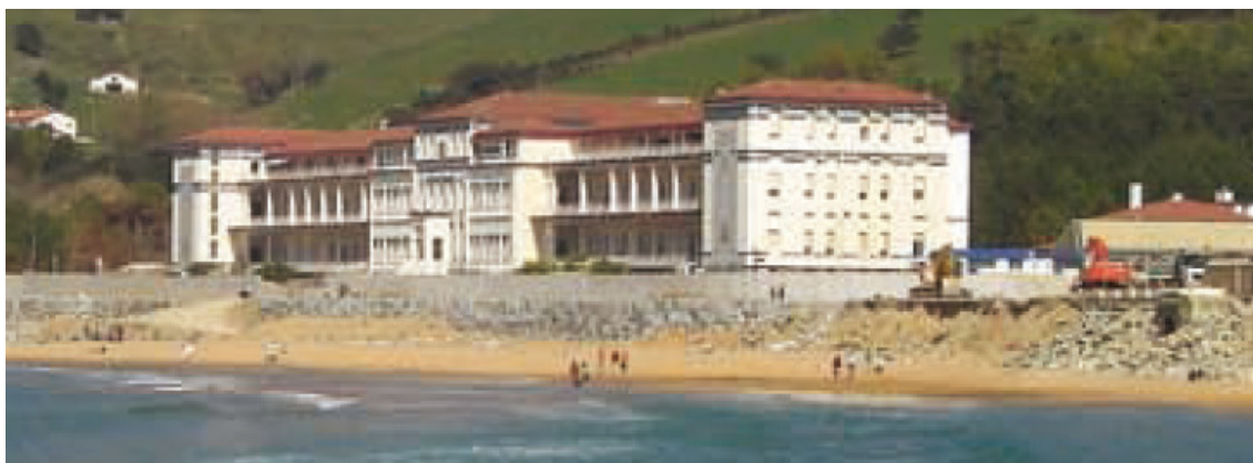
Ilustración 34: Ubicación del Hospital de Gorniz
