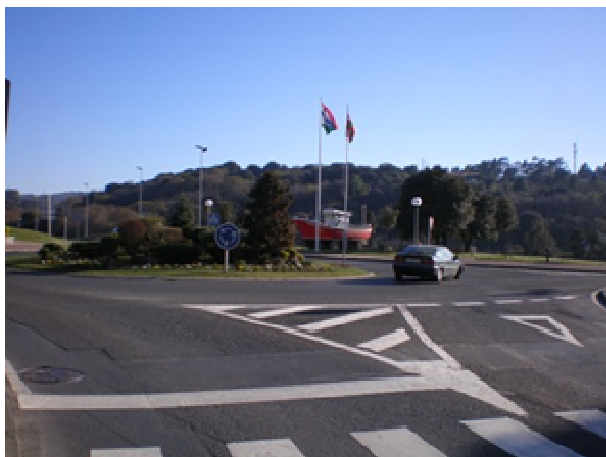
Ilustración 7: Rotonda de velocidad alta en Gorliz
