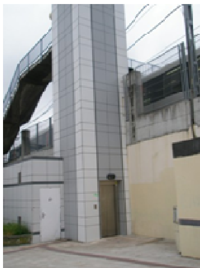
Ilustración 29: Ascensor del Metro de Berango
