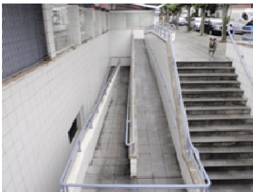
Ilustración 28: Rampa de acceso al metro de Sopelana
